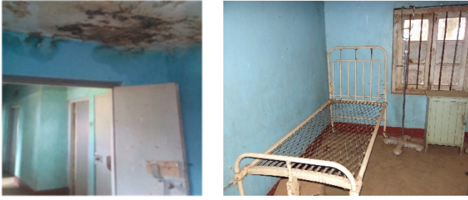
Ansicht im Hauptgebäude und Patientenzimmer
