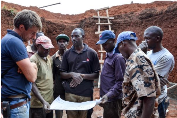
Bau der ersten 50m 3 Biogasanlage
